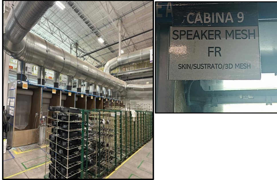
Ilustración 21: Identificación de cabina con parte de Wrapping.
